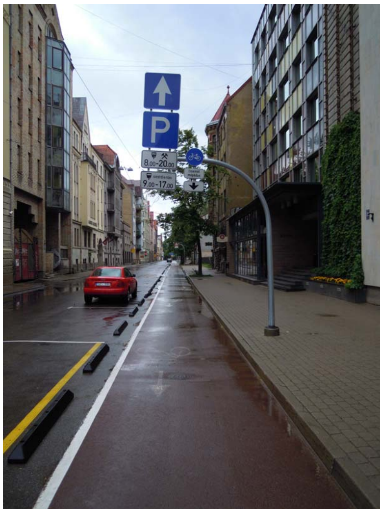
Obr. 18 - Vyhrazený jízdní pruh pro cyklisty oddělený recyklátovým obrubníkem (tzv. "parkovacím dorazem") v Rize (Lotyšsko)
