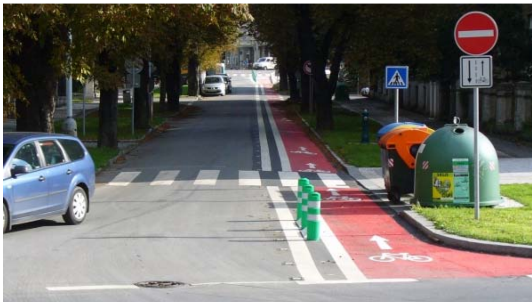
Obr 6 - Balisety (zelené) a dopravní knoflíky (ve vozovce) oddělující cyklopruh v Praze - Bubenči (zdroj: http://doprava.praha-mesto.cz )
