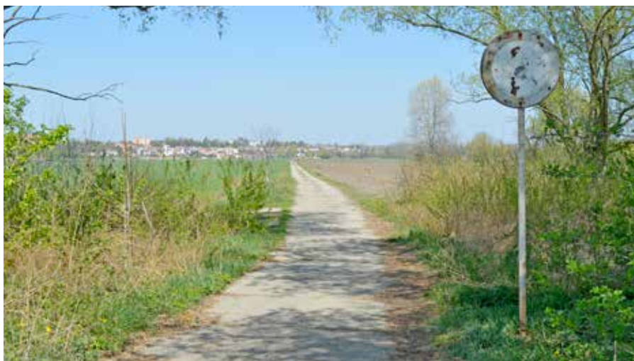
Stávající stav panelové cesty před napojením na ul. Legionářů
