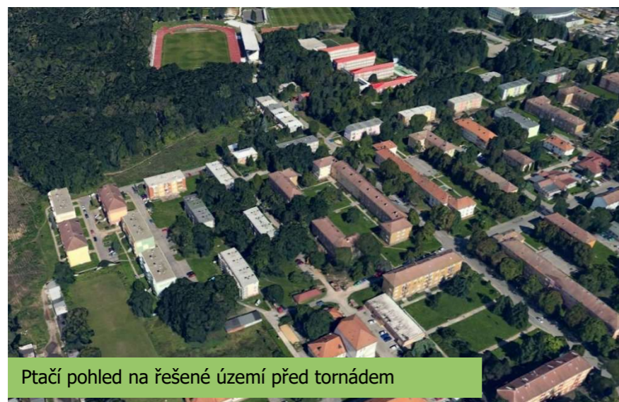
Letecký pohled na řešené území (24.7.2021)
